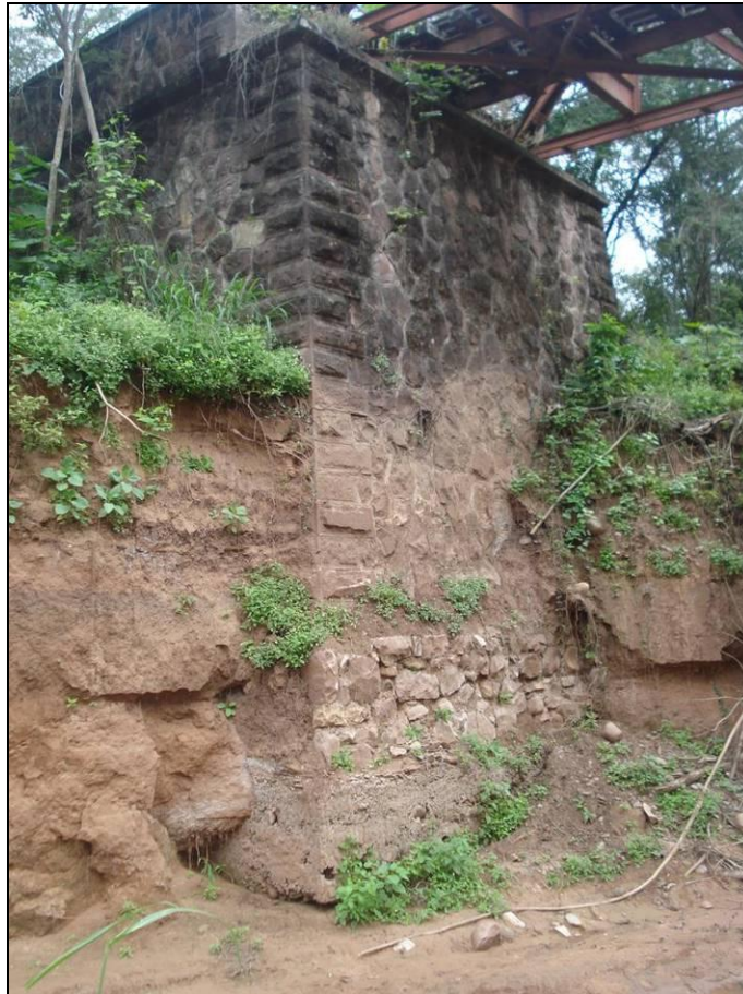
Foto N° 3: Estribo Margen Derecha desde aguas abajo.
