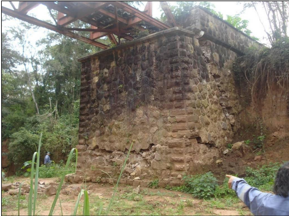
Foto N° 2: Estribo Margen Izquierda desde aguas abajo.
