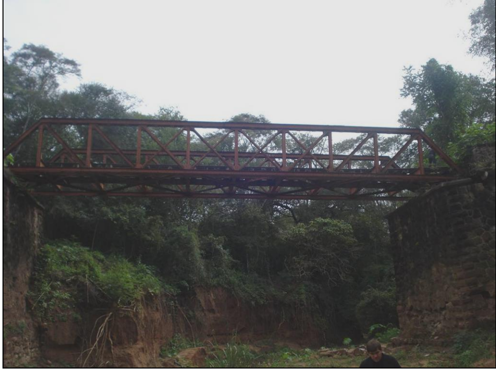
Foto N° 1: Panorama general de los estribos y el puente desde aguas abajo.
