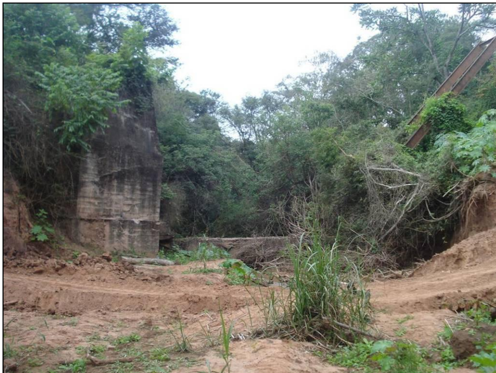
Foto N° 5: Estructuras existentes aguas debajo de la obra de arte sobre el cauce del arroyo.
