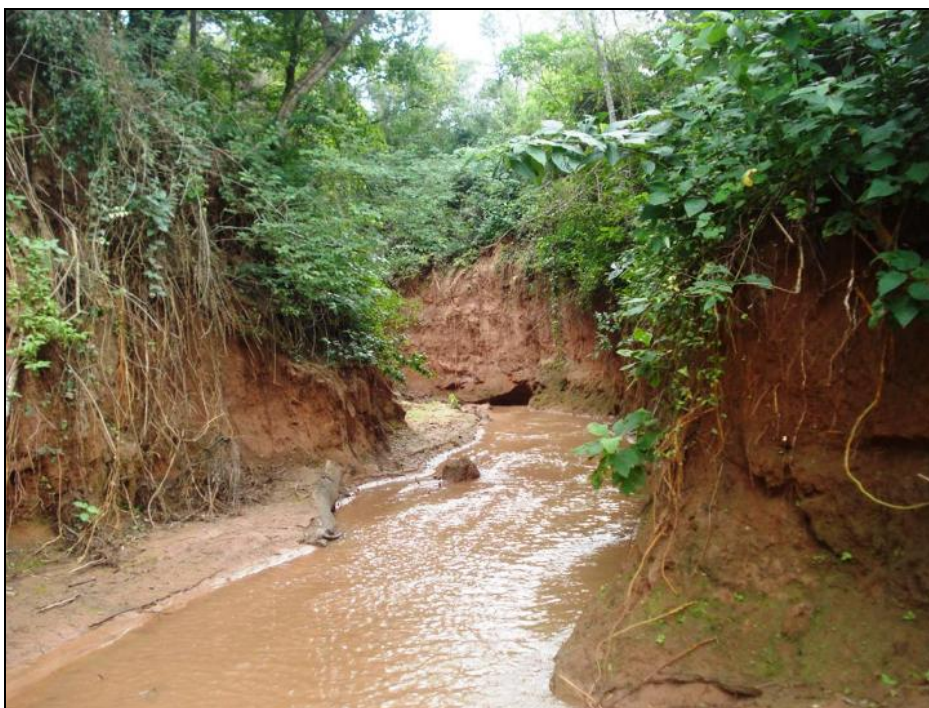
Figura N° 3: Panorama del cauce del Arroyo Zanja Honda hacia aguas arriba del puente ferroviario.
